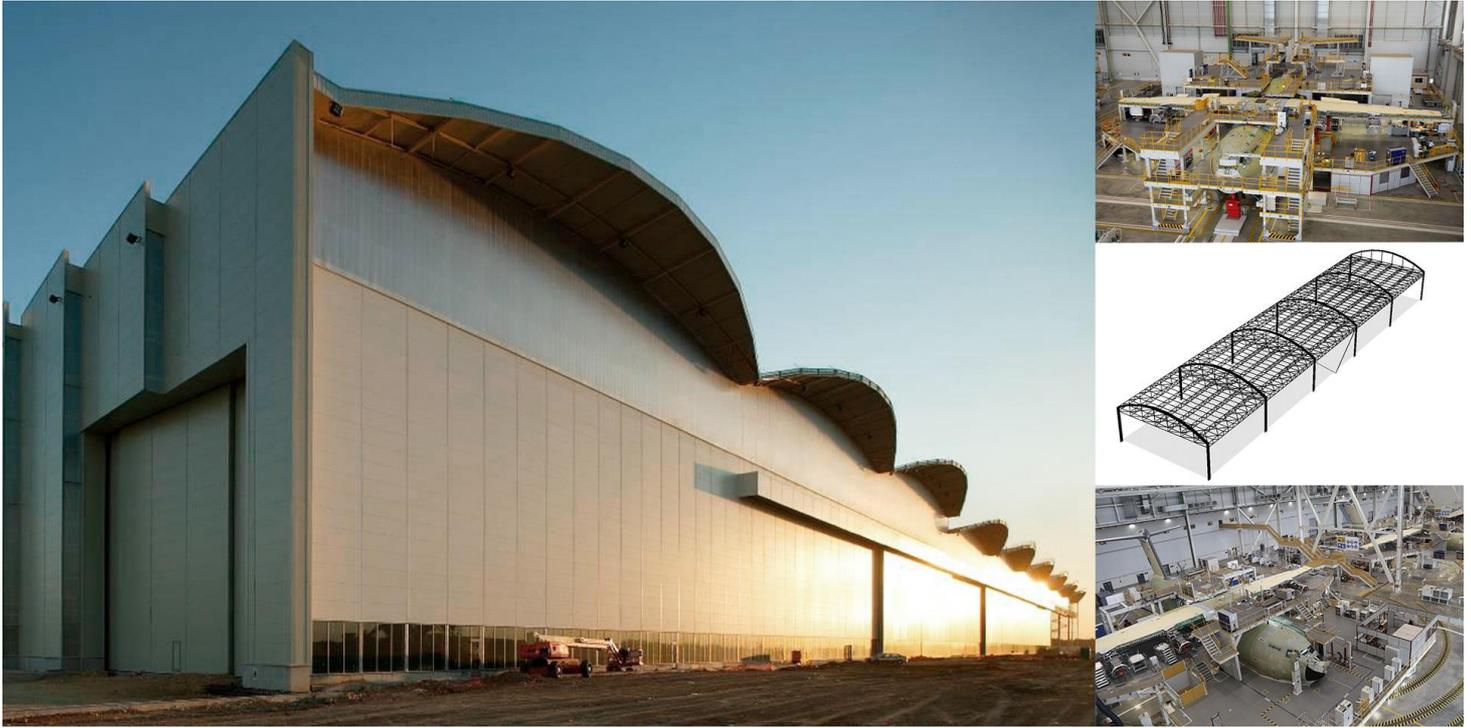
La planta de montaje del avión de transporte A400M está formada por nueve módulos distribuidos en dos hangares ( 4+5) que flanquean a ambos lados el bloque del edificio central o espina. También constituyen parte de la planta el hangar del taller de pintura y otras estructuras de menor rango como las marquesinas peatonales, el edificio de control de la entrada y una torre.
